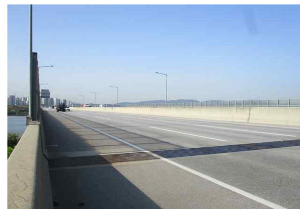
미사대교(양양) 상부 전경
